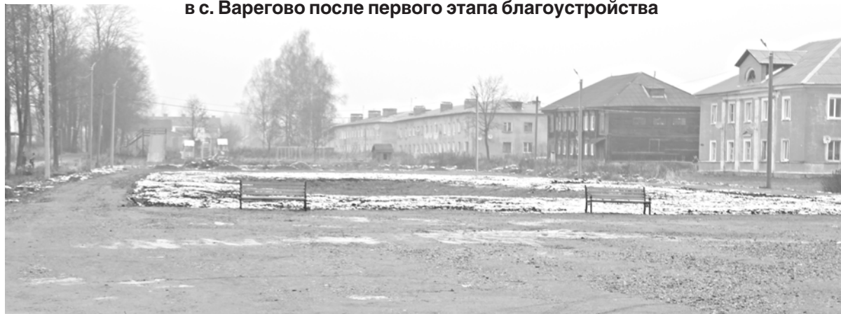
Общественная территория по ул. Мира в с. Варегово после первого этапа благоустройства
